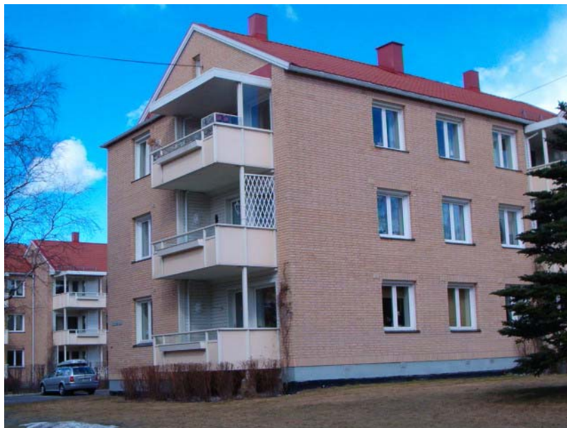
Blokkene etter renoveringen i 1997/98
